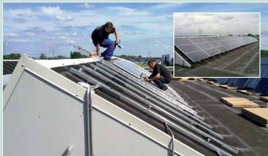
Монтаж солнечных коллекторов - Логистический центр - Блейсвик (Нидерланды)
