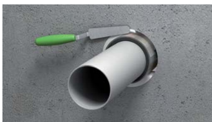
5. Заполните зазор пеной или строительным раствором
