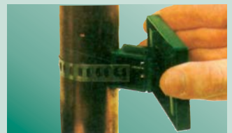
Nacvaknete držák na distanční blok
